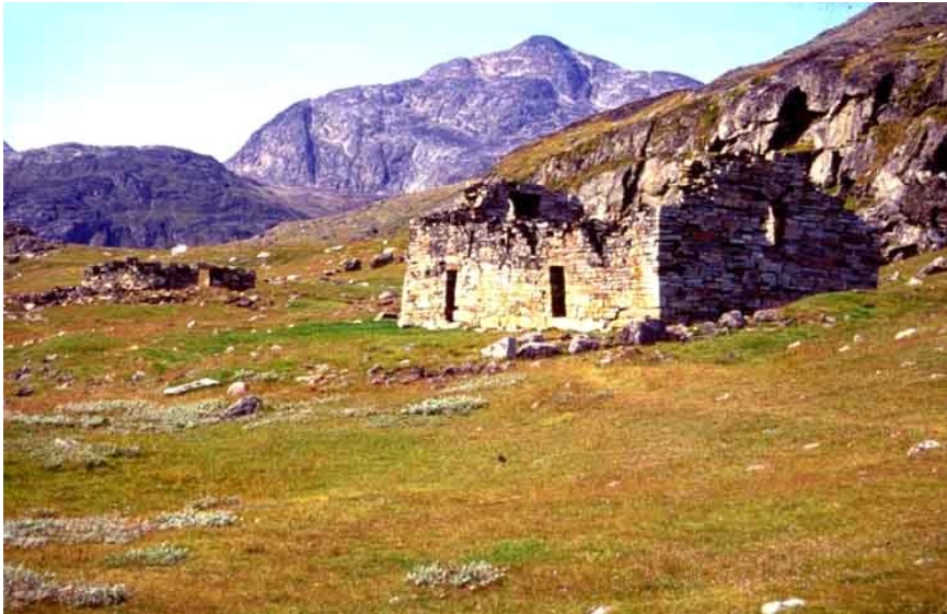
Figur 44. Hvalseð kirkeruin sett fra sydøst, slik den møter de besøkende i dag. Sydmuren og murkronen ble på slutten av 1990- tallet rettet opp og sikret.
