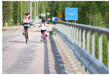
The bridge over Pajala to Kolari. Photo: Tornedalsrådet
